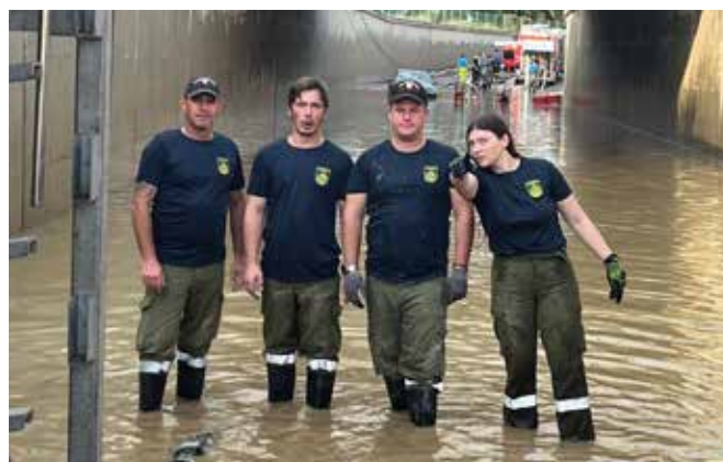
Bis zu den Knien im Wasser: Pumparbeiten bei einer ÖBB-Unterführung im Raum Tulln.
