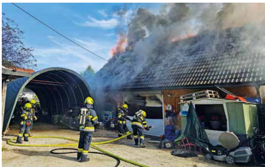
Der umfassende Löschangriff wurde von mehreren Atemschutztrupps vorangetrieben.
