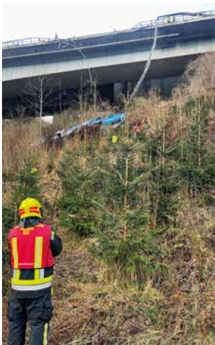
Blick auf die Autobahnbrücke mit den herabhängenden Leitschieneanteilen.
